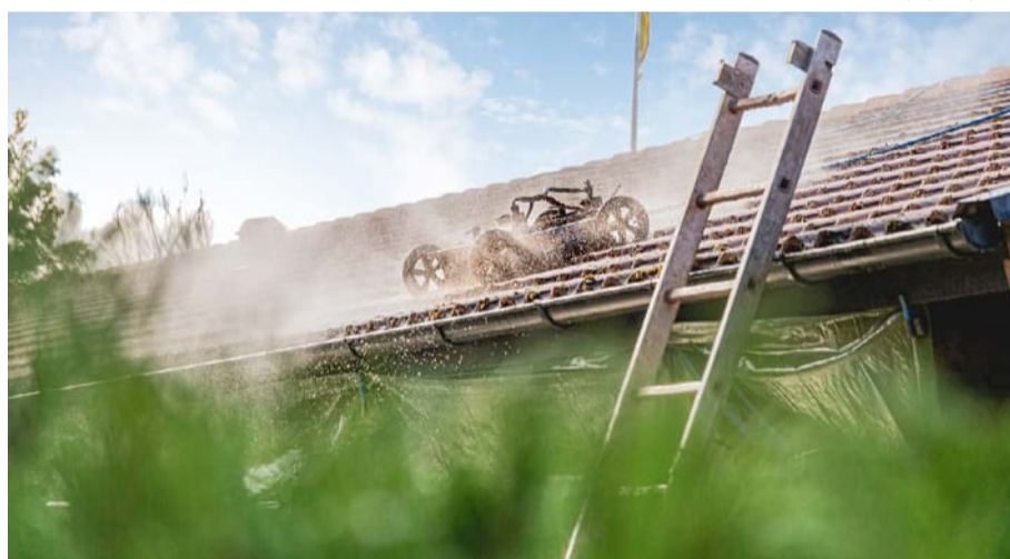
En specialanpassad högtrycksmaskin "robot" går upp och ner längs taket och tvättar takpannorna.
